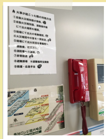
↑ 火災対処方法を火災通報装置 付近に掲示し、いつでも確認できる ようにしています。
